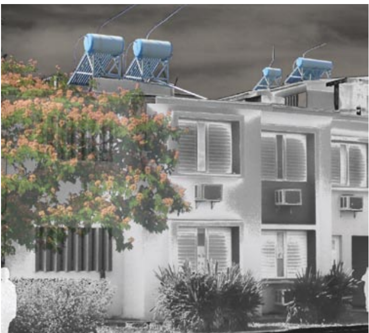
Figura 20: Calentadores solares en residencias.
