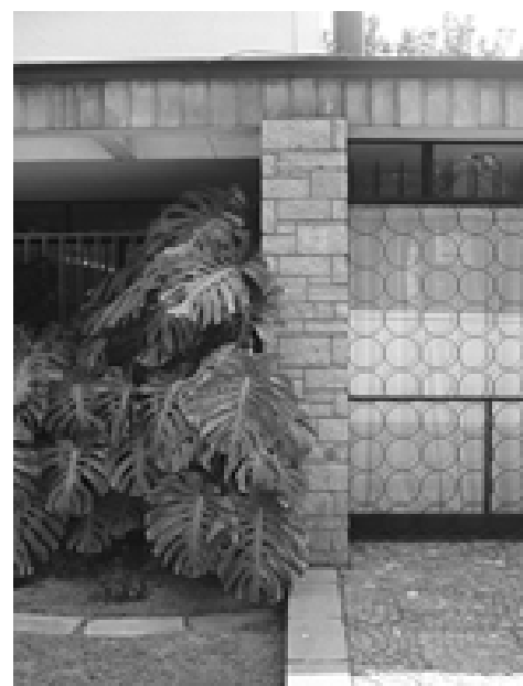
Figura 11: Diseño de reja en paño vidriado del estar. Fuente: archivo fotográfico del autor.
