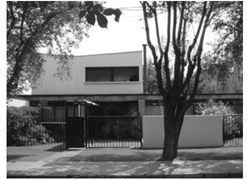
Figura 12: Construcción del cierre principal. Fuente: archivo fotográfico del autor.
