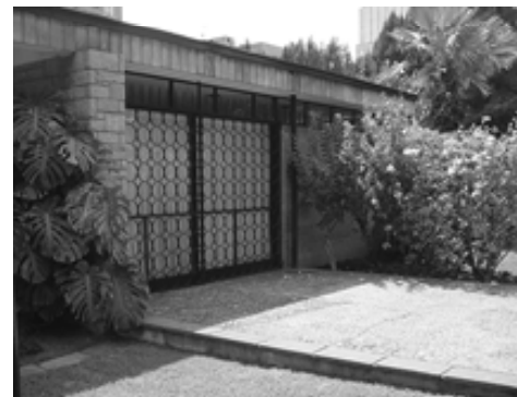
Figura 10: Fuente: El canto de la losa de cubierta se “posa” sobre muro transversal revestido en piedra Archivo fotográfico del autor.
