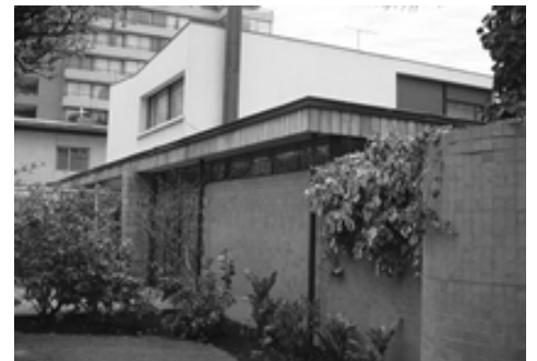
Figura 9: Construcción formal de losa de cubierta, tabiques de cierre y línea de vidrio alta sobre tabique. Fuente: Archivo fotográfico del autor.
