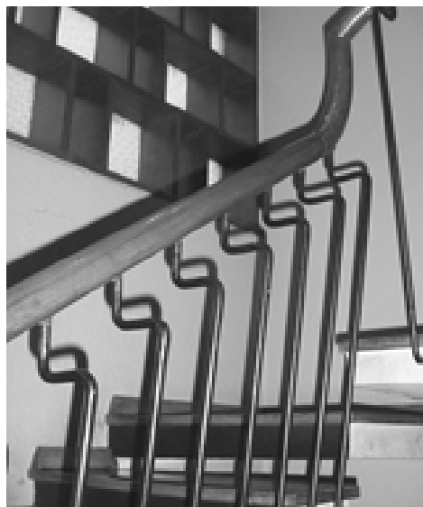
Figura 15: Fuente: Detalle de barandal de escalera. Fuente: Archivo fotográfico del autor.
