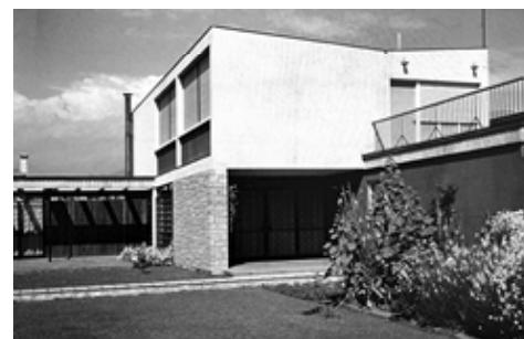
Figura 7: Muro longitudinal (pintado en tono oscuro, “emergiendo” debajo la pastilla de habitaciones del segundo nivel. Peldaño transversal, proyectado desde terraza cubierta del comedor hacia el jardín. Fuente: Archivo fotográfico del arquitecto Héctor Valdés Ph.
