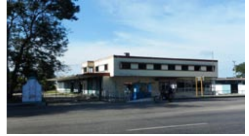
Figura 12: Embotelladora Cawy del Oeste, S.A. 1952- 1953. Arq. Roberto Franklin. Avenida de Boyeros y Línea del Ferrocarril. Boyeros.
