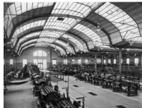
Figura 1: El hormigón armado y el vidrio hicieron posible cubrir grandes luces y tener espacios ventilados e iluminados.
