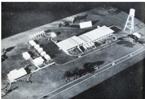
Figura 10: Fábrica de pinturas Du Pont . km 39 de la carretera Central, San José de las Lajas. Arqs. Raúl Álvarez y Enrique Gutiérrez junto con la firma Sáenz, Cancio y Martín. Fuente: Álbum de Cuba
