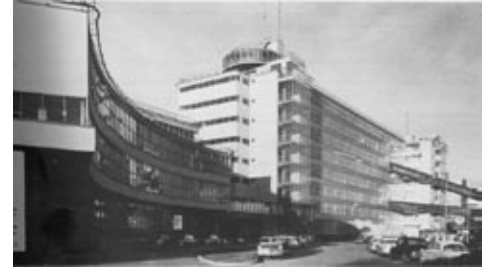
Figura 3: Fábrica Van Nelle, Rotterdam, 1930. Arqs. Brickman y Van der Vlugt. Hoy refuncionalizada como un centro cultural.
