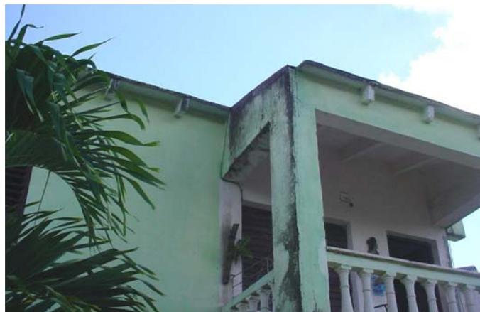
Deterioros causados por la humedad y agudizados por insuficientes soluciones de diseño.
