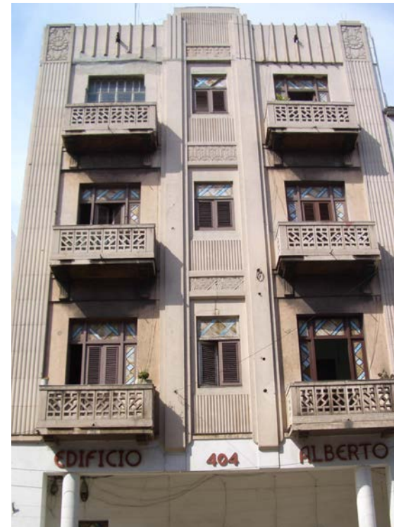
Figura 5: Edificio de apartamentos en Reina No 408 entre Gervasio y Escobar, Centro Habana con fachada Art Deco. [8]
