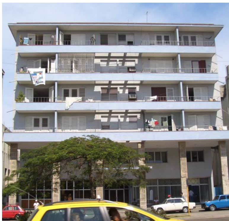
Figura 11: Imagen del edificio de apartamentos del movimiento moderno en Carlos III No 704 entre Castillo y Soledad, Centro Habana, 1954 [8].
