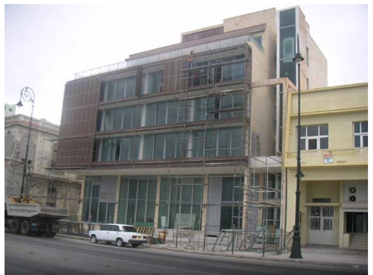
Figura 21: Hotel Terral. Fuente: Autores.
