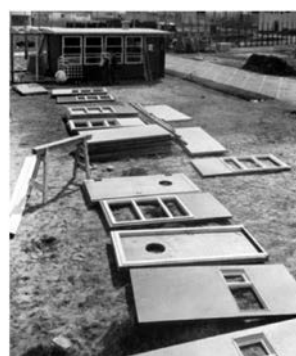
Figura 21: Modulación de los elementos componentes de cierres exteriores y de división interior para facilitar su sustitución. Proyecto Werfthaus, Otto Bartning, Alemania, 1932 y Proyecto Les Marelles, Bernard Kohn y Georges Maurios, Francia, 1975, respectivamente. (Tomadas de http://www.afewthoughts.co.uk , marzo 2010)
