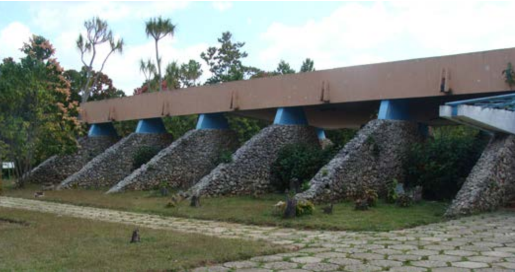
Figura 18. El gran techo de la cafetería El Galápagos de Oro empleó la estructura de una antigua vaquería existente en el lugar.
