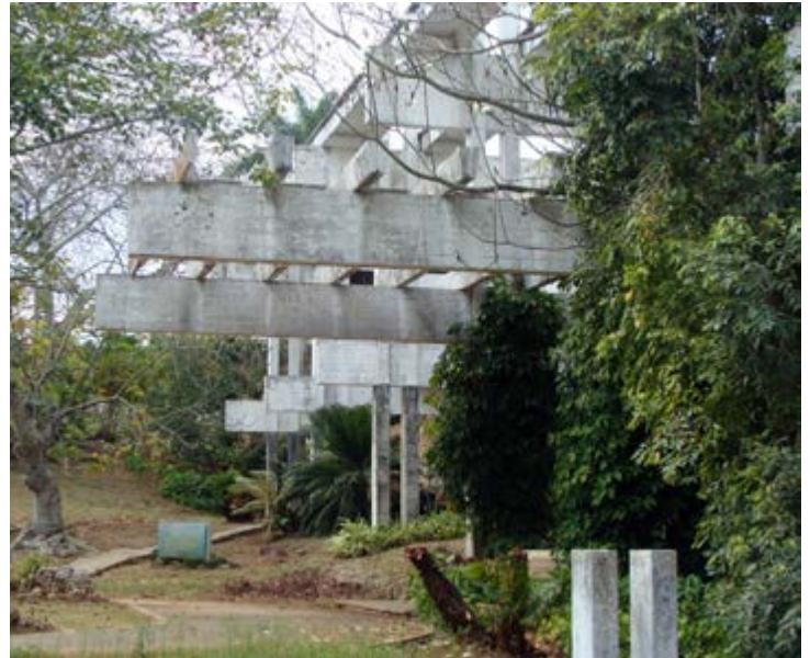
Figura 3. En la arquitectura del restaurante Las Ruinas se destaca la estructura de elementos prefabricados de ortogonal geometría.
