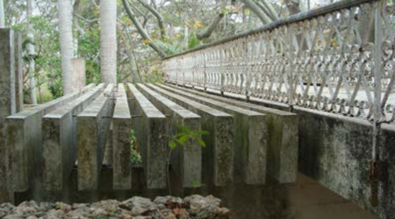
Figura 7. Las barandas del piso alto, así como las de la escalera y los balcones, fueron trabajadas con herrería forjada.
