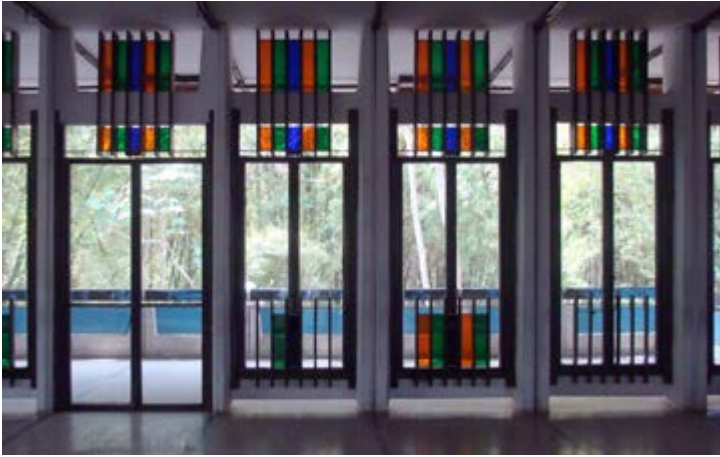
Figura 12. El cierre se resolvió con el elemento prefabricado diseñado para el parque, que sirve de marco para la carpintería.
