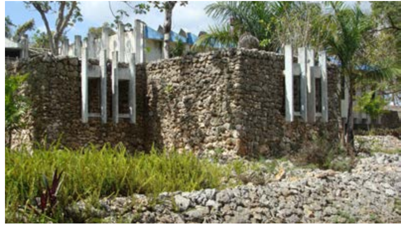
Figura 14. Los servicios sanitarios fueron ubicados al exterior para que pudieran ser usados por otros visitantes del parque.
