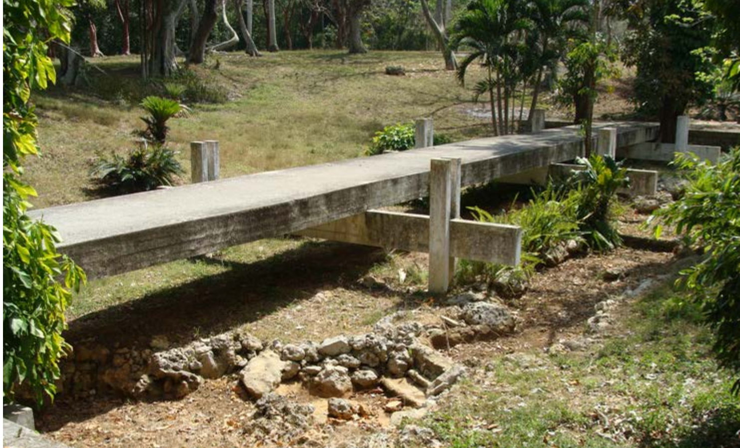
Figura 5. En la arquitectura del restaurante Las Ruinas se destaca la estructura de elementos prefabricados de ortogonal geometría.
