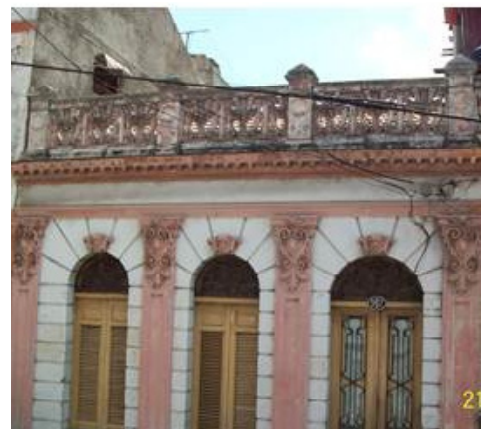
Figuras 2, 3 y 4: Viviendas eclécticas con lesiones por humedad. Fuente: Autores
