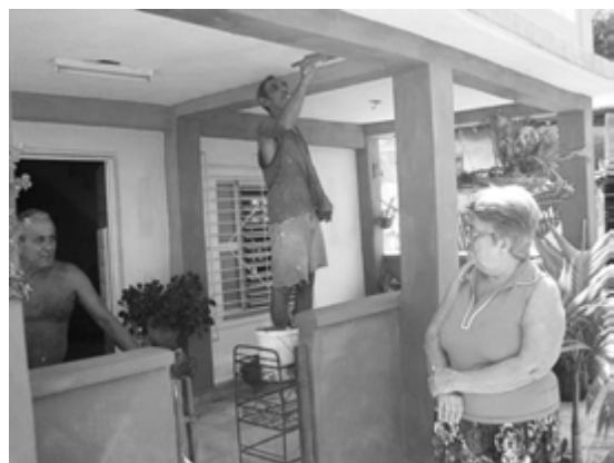
Figura 7: Vivienda en construcción por esfuerzo propio en el barrio “El Platanito”, ciudad de La Habana. Foto tomada por la autora, octubre del 2009
