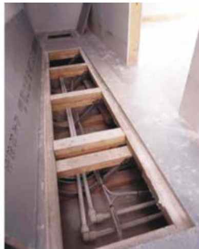
Figura 15: Flexibilidad tecnológica racional. Instalaciones eléctricas expuestas, Monerau, Les Freres-Arsene-Henry, Francia, 1971 ( www.afewthoughts.co.uk , febrero 2010) y Conductos registrables de instalaciones horizontales y verticales ( www.afewthoughts.co.uk , febrero 2010).
