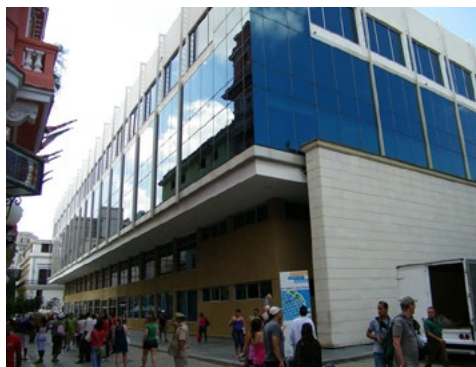
Figura 3: Fachadas de vidrio totalmente selladas y sin protección solar. Universidad de San Jerónimo, La Habana. (Fuente: Lester Alonso, 2011)
