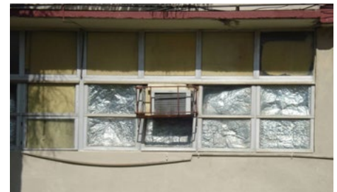
Figura 9: Ventanas de vidrio tipo marquesinas sin protección solar en una fachada del edificio de sanidad vegetal que muestran su desuso como fenestración traslúcida necesaria en el interior del laboratorio.
