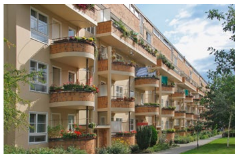
Figura 6. Siemensstadt, Berlín (1929-1930), declarado Patrimonio de la Humanidad en 2008, un ejemplo de construcción de viviendas sociales por parte de una empresa.
