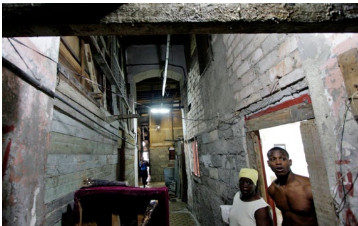
Figura 2. Vivienda dañada en La Habana.
