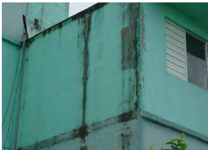
Patologías causadas por el agua de escurrimiento por diseño inadecuado.
