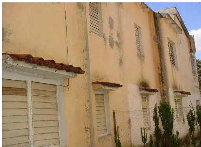
Fachada con patologías derivadas de errores de diseño de los paramentos verticales.
