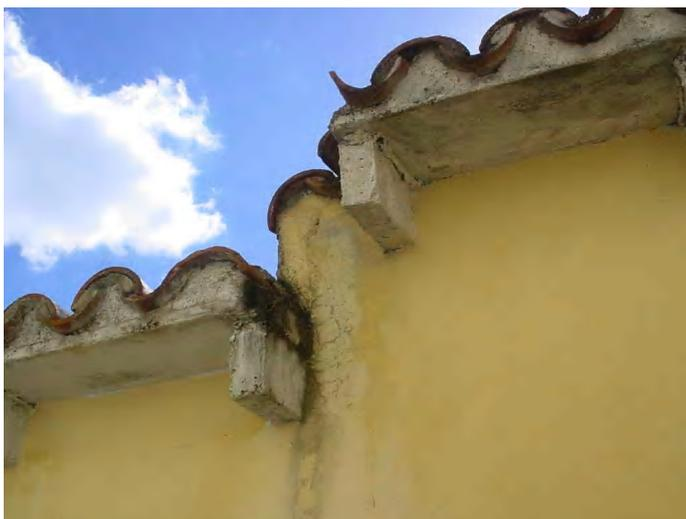
Solución inadecuada de diseño y detalles en parte superior de paramentos.
