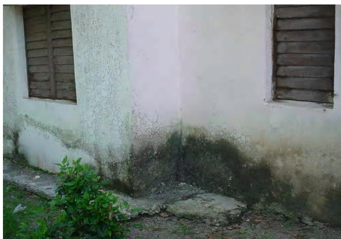
Patologías por humedad debido a solución errónea de detalles.
