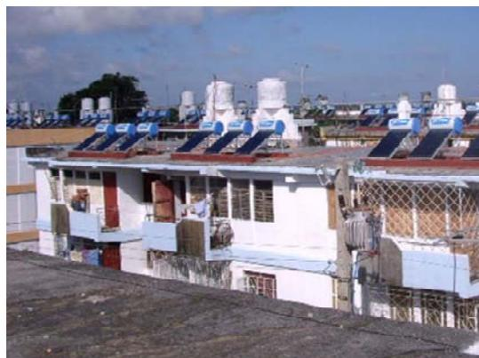
Calentadores solares de tubos al vacío de fabricación china instalados de forma experimental en un edificio de viviendas en la Isla de la Juventud.
