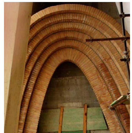
Viga de arriostre en la cantoría del ábside, que quedó sobredimensionada y genera problemas con el encofrado de la piel. Se redujo la viga por un lado para lograr que la forma geométrica final externa, no quede alterada y se estudió nuevamente su comportamiento estructural-mecánico.
