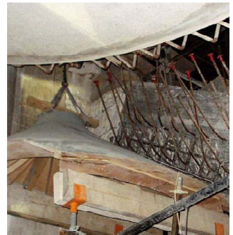
Viga de arriostre en la cantoría del ábside, que quedó sobredimensionada y genera problemas con el encofrado de la piel. Se redujo la viga por un lado para lograr que la forma geométrica final externa, no quede alterada y se estudió nuevamente su comportamiento estructural-mecánico.
