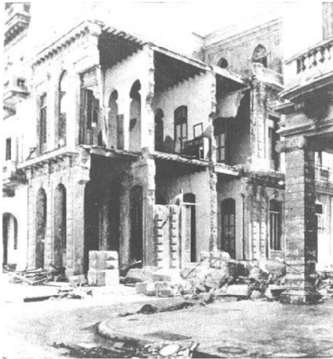
Derrumbe en Malecón y Campanario, provocado por el huracán de 1926. 4
