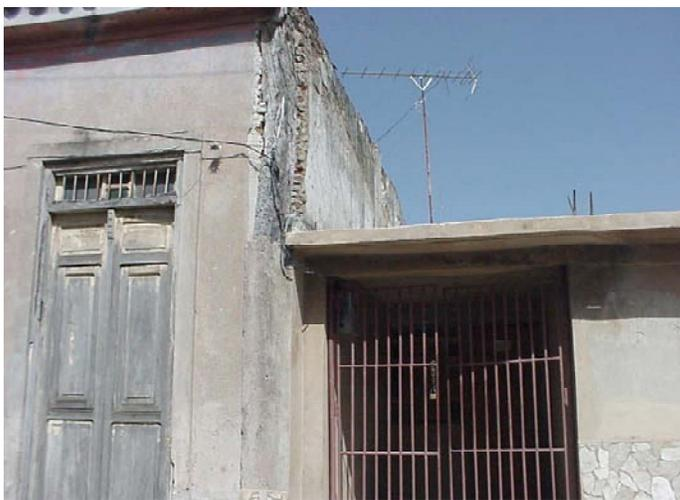
Inmuebles con cubiertas de losas de hormigón, descargan las aguas pluviales hacia las paredes de las viviendas aledañas y las hacen vulnerables ante un evento sísmico.
