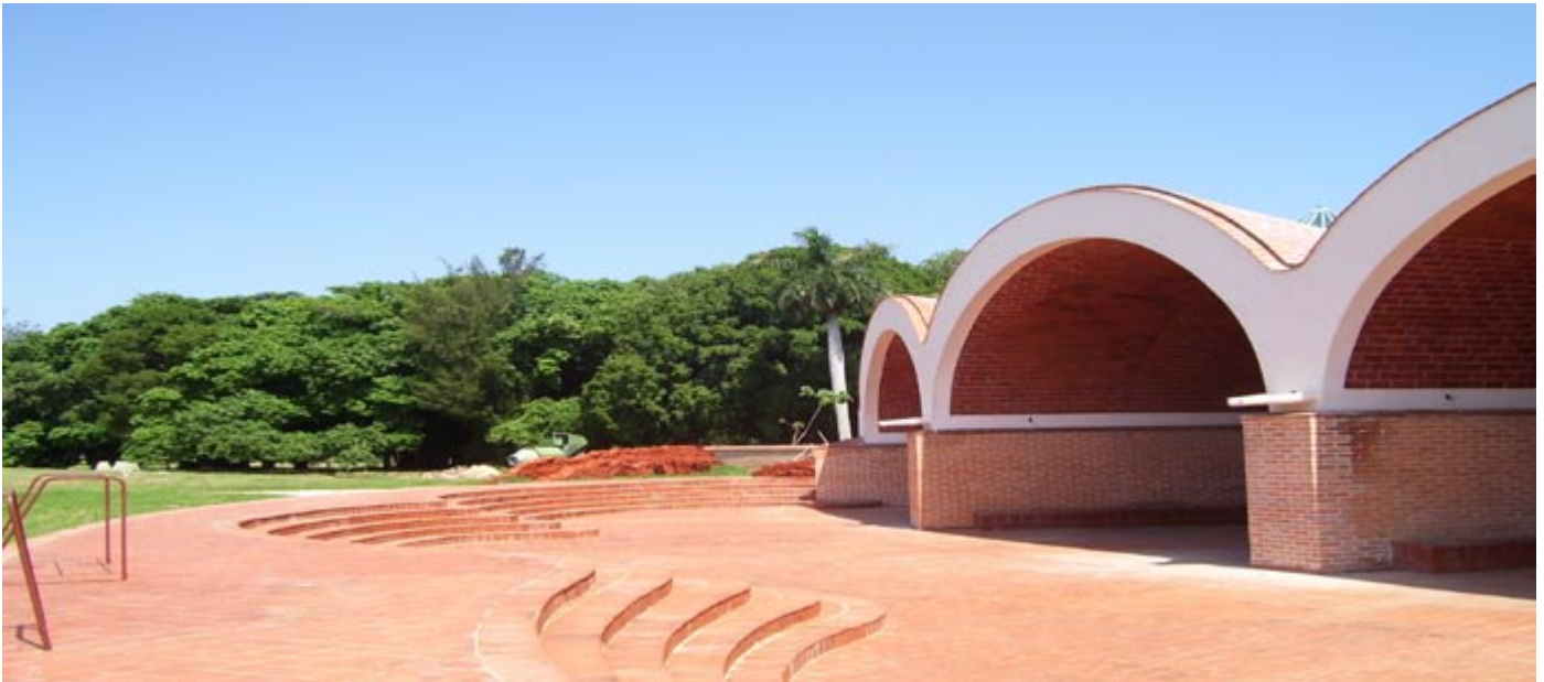
Figura 18. Escuelas de arte de Cubanacán, Escuela de Artes Plásticas Ricardo Porro.
