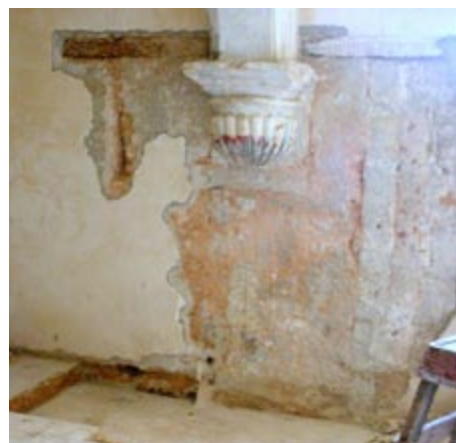
Figura 17. Ménsula y arranque del arco insertados en un vano tapiado.
