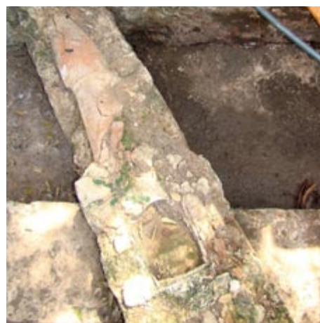
Figura 9. Conducto que une el vaso de la fuente con un baño.
