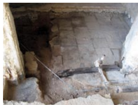
Figura 18. Pavimento de losas isleñas.
