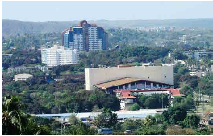
Imagen 18. Grandes instalaciones de servicio en la Avenida de Las Américas. (Fuente: Elena Cambón, 2009).
