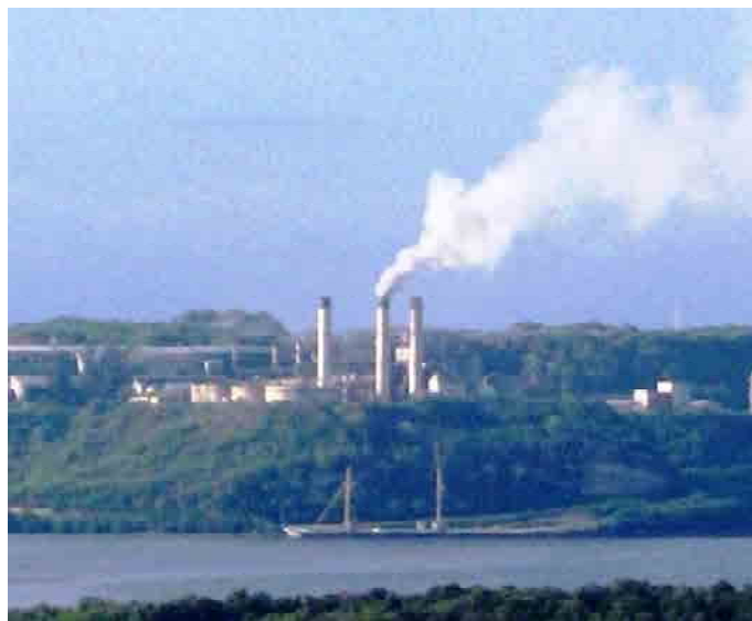
Imagen 16. Fábrica de Cemento José Mercerón. (Fuente: Elena Cambón, 2009).
