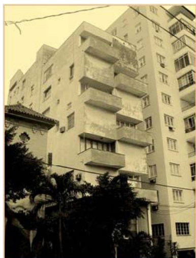
Foto 7. Edificio Anter. Arquitecto Max Borges, Vedado. Foto Ruslan.
