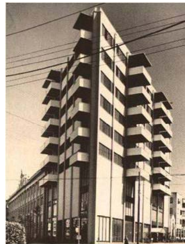
Foto 6. Edificio Partagas. 1953. Arquitecto Max Borges, Vedado.
