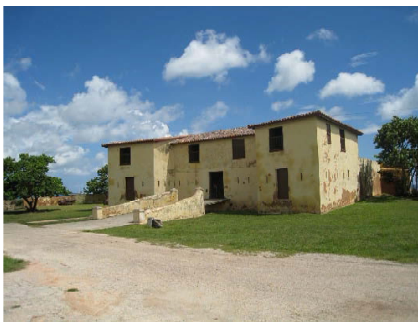
Fuerte El Morrillo convertido en Museo Memorial, donde se realizaron las primeras labores arqueológicas vinculadas a la restauración del patrimonio en Matanzas.
