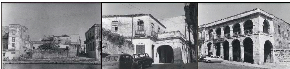
Figura 11. Imágenes que muestran el deterioro del entorno de la Vigía durante la República.
