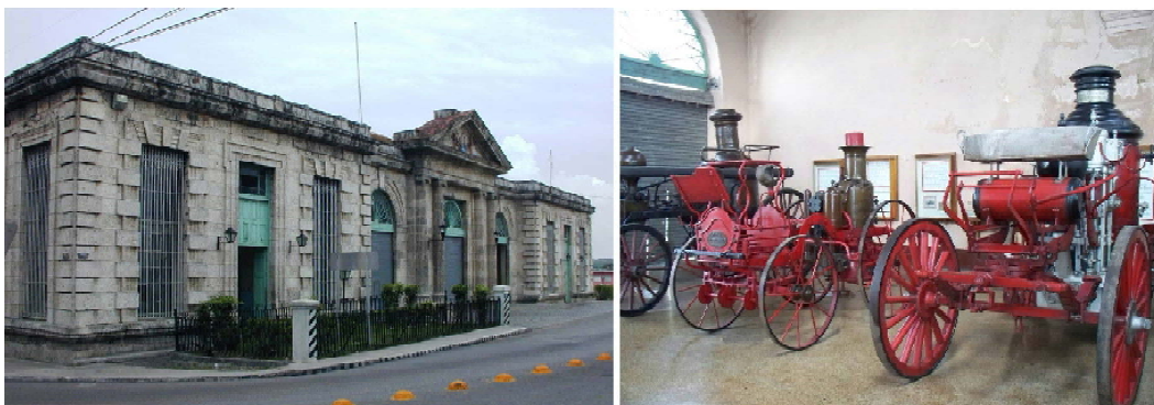
Figura 15. El Cuartel de Bomberos utiliza el mismo acceso para el Museo de las Bomberos y la estación, peligroso conflicto de funciones.
