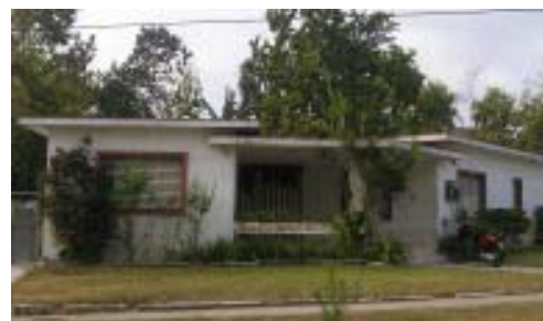
Anacaona No.152. La edificación se adapta a la forma trapezoidal del lote.
