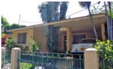
Vivienda en Calle I, No. 322 en el reparto Sueño
